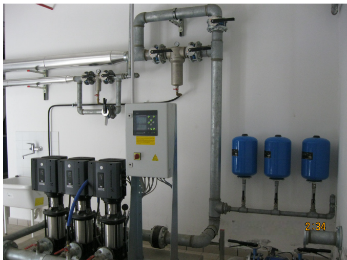
Nella foto sopra: Il gruppo di aumento pressione a velocità variabile per l'adduzione di acqua potabile ha una portata di 48 m 3 /h e una prevalenza di 44 m.c.a.
