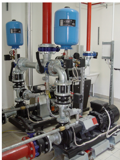
Nella foto sopra: Il gruppo di aumento pressione a velocità variabile per l'adduzione di acqua potabile ha una portata di 48 m 3 /h e una prevalenza di 44 m.c.a.
