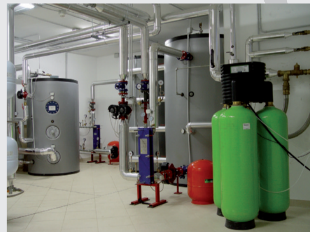
VISTA BELLA CENTRALE solare di produzione e accumulo ACS.
