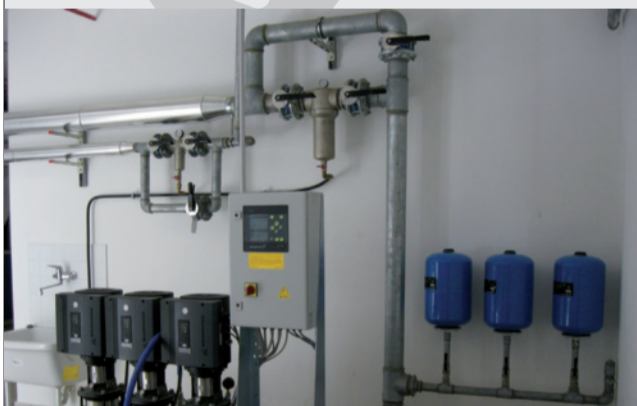
IL GRUPPO DI AUMENTO PRESSIONE a velocità variabile per l'adduzione di acqua potabile ha una portata di 48 m 3 /h e una prevalenza di 44 m.c.a.
