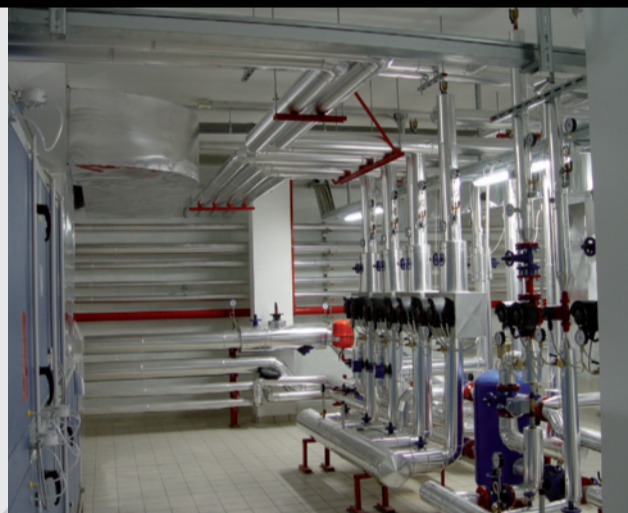
VISTA BELLA CENTRALE solare di produzione e accumulo ACS.
